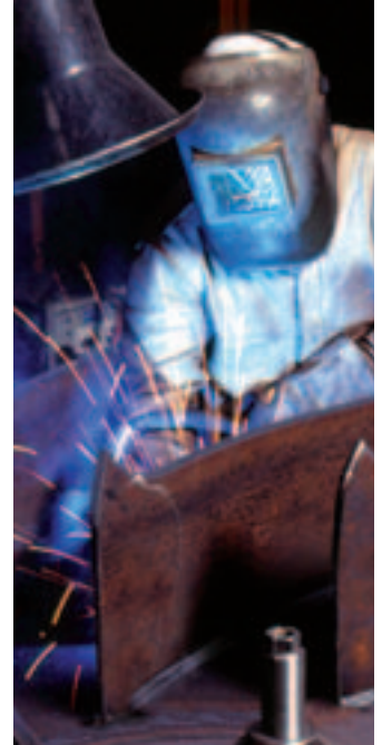
Schweißarbeiten an einem zu reparierenden Laufrad
