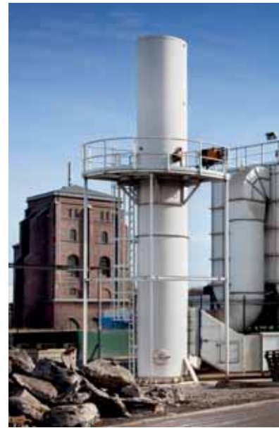
Erweiterung der Filteranlage
