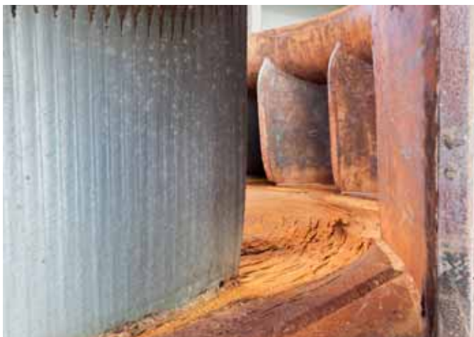
Bild 2 Verschleiß an Industrieventilatoren nach Einsatz [2] a) Auswaschung am Bodenblech
