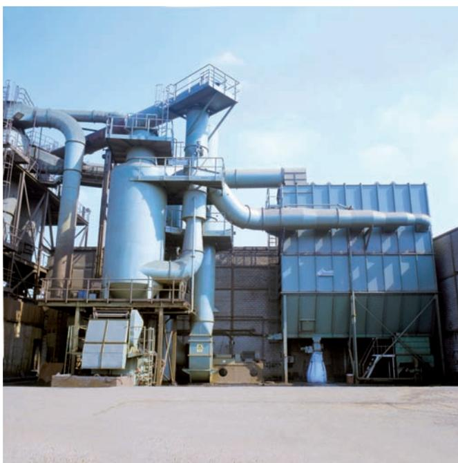
Alternativ wählen wir das Entstaubungsaggregat für den jeweiligen Einsatzfall mit Bedacht aus. Ein Beispiel hierfür ist die Möglichkeit der Umschaltung, wenn im Shredder keine Explosionen zu erwarten sind. Dann kann auf ein entsprechendes Trockenfilter umgeschaltet werden, das eine noch bessere Abluftqualität garantiert als unsere Nassentstauber.
