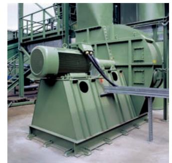
Für aggressive Gase, wie sie beispielsweise in Müllverbrennungsanlagen hinter dem Ofen anfallen, liefern wir Ventilatoren aus korrosionsbeständigen Materialien.
