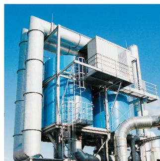
Zum Lieferumfang gehört auch die Behandlung von geruchsbelasteter und kohlenstoffhaltiger Abluft. Hier können neben klassischen Biofiltern auch Biowäscher mit Tropfkörpern eingesetzt werden.
