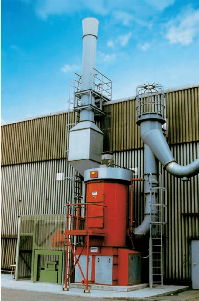
Ausreichend dimensionierte Druckentlastungsflächen in den Rückluftleitungen und eine 180° Luftumlenkung verhindern eine Ausbreitung der Druckwelle in die Fabrikationsräume.
