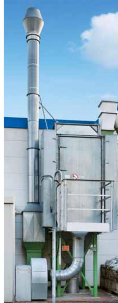
Bei der Beschichtung, etwa beim Flammsspritzen, Galvanisieren oder Feuerverzinken, entsteht Abluft, die mit Gasen und Stäuben verunreinigt ist. Die Menge und Zusammensetzung beim Feuerverzinken hängt primär vom verwendeten und beim Verzinken verdampfenden Flussmittel ab, darüber hinaus auch von der übrigen Vorbereitung (Entfetten, Beizen und Trocknen).
