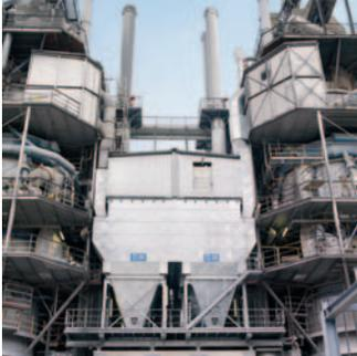
Sehr feine Stäube verlangen besondere Abscheidesysteme. Gleiches gilt für faserige, klebrige, feuchte und schwer agglomerierbare Stäube. Prozesse mit hoher Staub- und Materialkonzentration erfordern Filteranlagen, die auch dann konstant zuverlässig arbeiten, wenn die Filterflächen maximal belastet werden.
