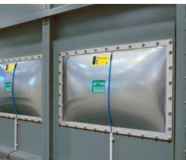
Als weitere Schutzmaßnahme können wir einzelne Anlagensysteme explosionstechnisch entkoppeln, um die Druckwelle abzuleiten. Rückschlagklappen in den Rohgasleitungen schützen andere Anlagenkomponenten und verhindern eine Ausbreitung der Druckwelle in die Fabrikationsräume. Die Explosion wird über ausreichend dimensionierte Druckentlastungsflächen gerichtet entspannt.
