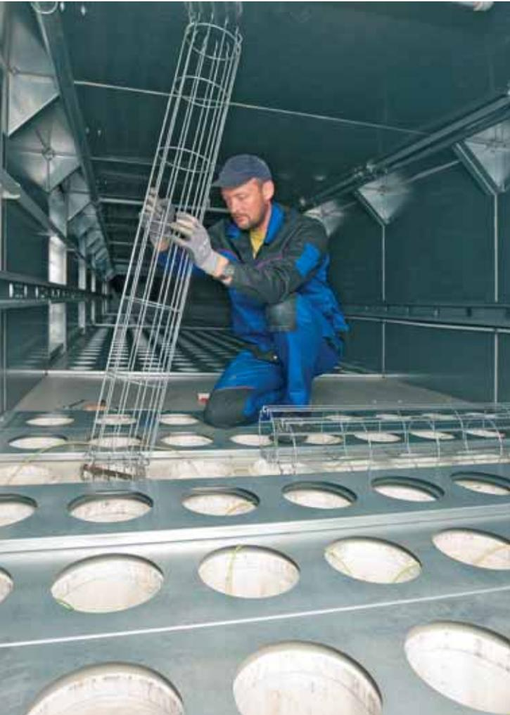
Altanlagen aufzuarbeiten, ist eine kostengünstige Alternative zur Neubeschaffung. Die instand gesetzten Anlagen werden nach Abschluss der Arbeiten geprüft. Verschleißteile werden gegen neue ausgetauscht.
