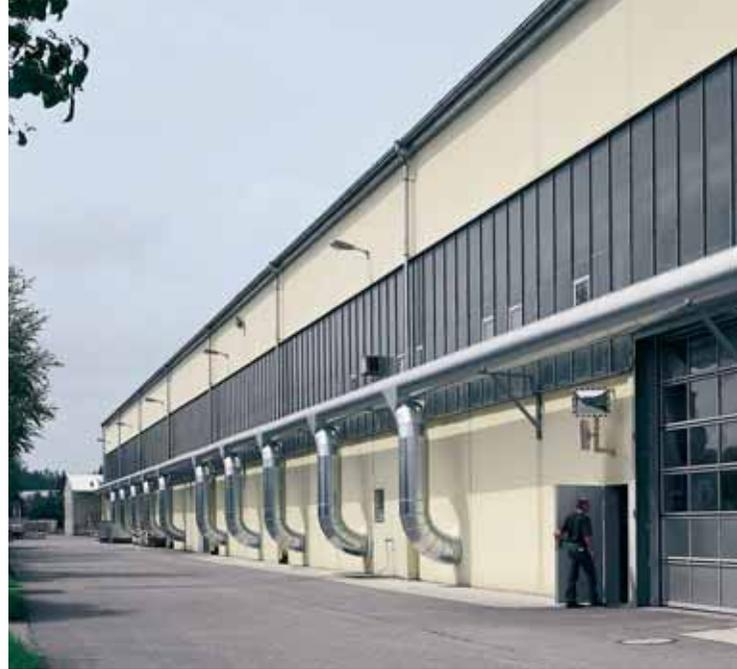
Pneumatische Förderanlagen sind eine interessante Lösung für die Entsorgung oder Zuführung von Schüttgütern in den Produktionsprozess. Unterschiedlichste Schüttgüter können zur Lagerung oder Verladung in Silostationen transportiert werden.
