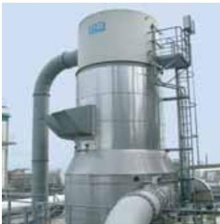
Zum Abscheiden großer Mengen Schüttgut haben sich unsere robusten und wartungsarmen Rundfilter mit integriertem Zyklonvorabscheider bestens bewährt. Sie werden als Endabscheider für pneumatische Förderanlagen eingesetzt.
